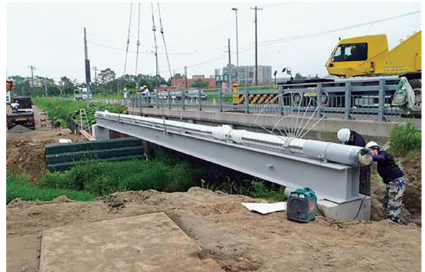
道内ガス事業者 中圧ガス本管専用橋設置工事
