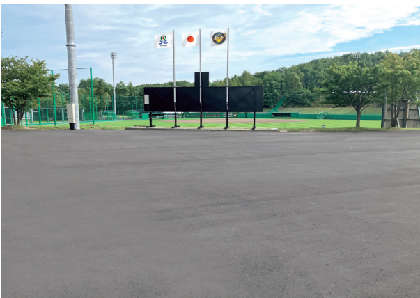
北ガスてん太の森公園／外構舗装工事
