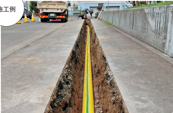
札幌市内 低圧ガス管敷設工事
