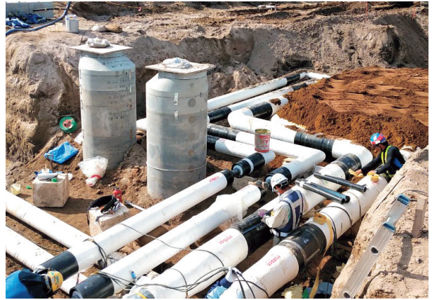
新札幌再開発事業 熱導管敷設工事
