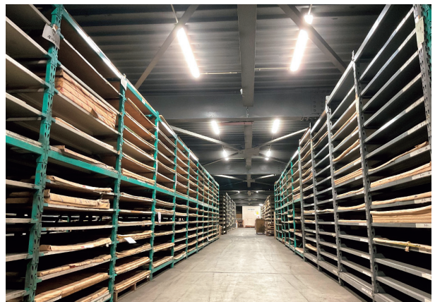
株式会社サクマ東営業所さま 照明器具LED更新工事
